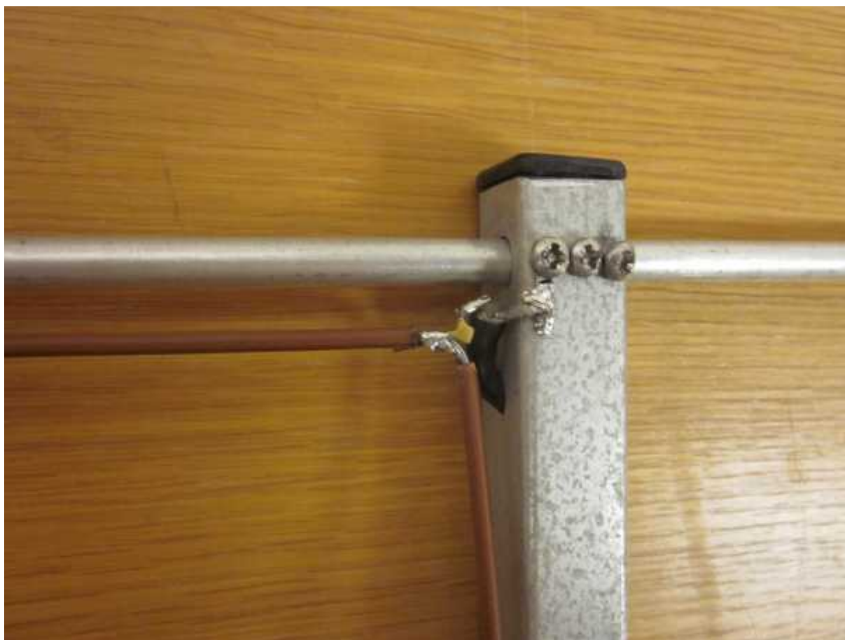
Detalj av anslutning koax och anpassningskondensator.
