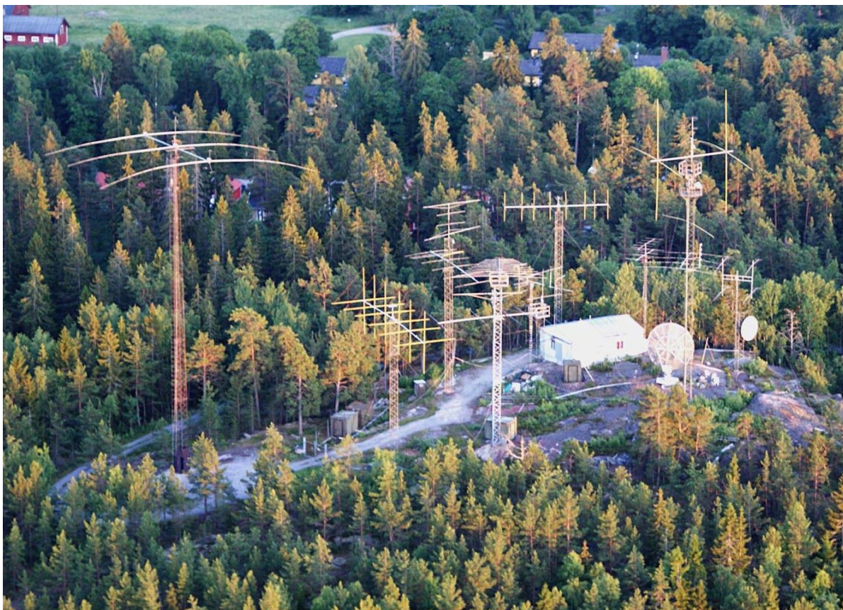
Delar av Kvarnbergets Amatörradioförenings experimentella antennenläggning i Täby/Vallentuna. Antenner och Antennarrayer mellan 1,8MHz till 24GHz.
